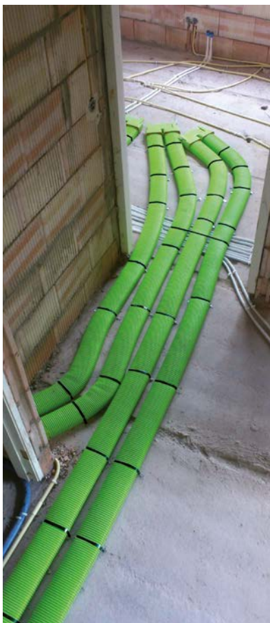
Nieuwbouw woning Heino
